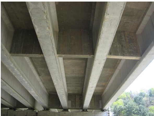
거더 및 바닥판하면 전경
