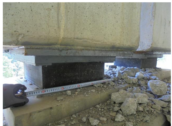
교량받침 이동량 측정
