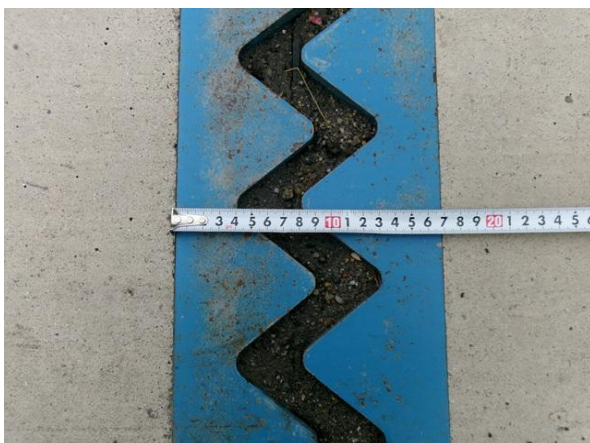
신축이음 여유량 측정
