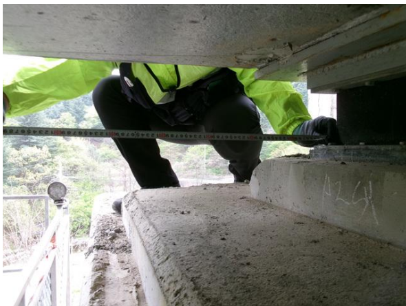
교량받침 제원 측정
